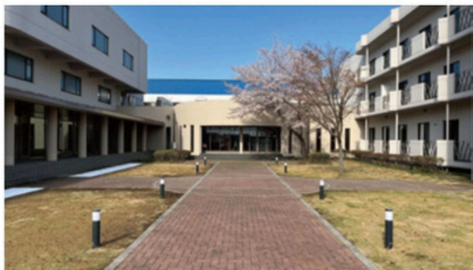
本館 (正面:候補生玄関、右側:候補生宿舍)
